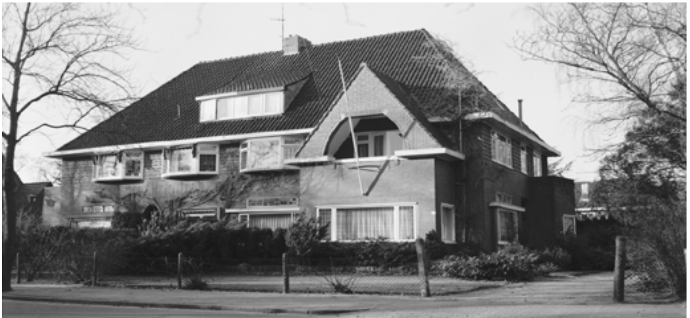
Onder het dak van dit gebouw bevonden zich twee villa's. De rechterhelft was Kamplaan 8, de woning van de familie Serphos vanaf 1934
